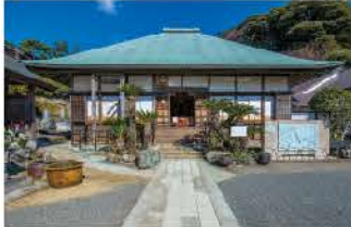
銅版葺きの屋根が見事な本堂
