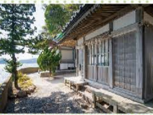
松陰先生が隠れた柿崎弁天社
