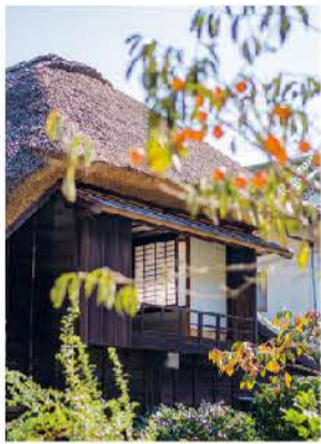
茅葺屋根に情緒を感じる施設
