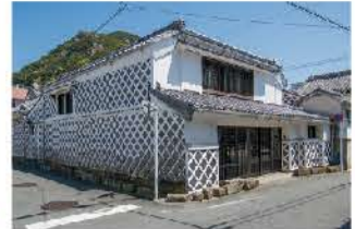
記念撮影スポットになっている南側正面
