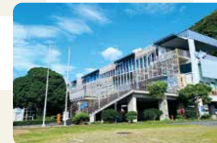
2階には開放的な広いデッキがある道の駅
